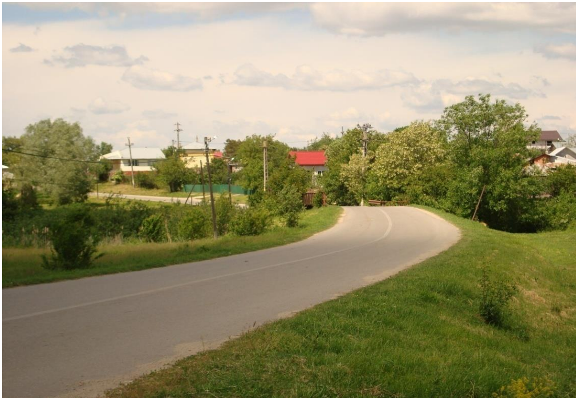
Fig. 51. Drum asfaltat în comuna Niculești
